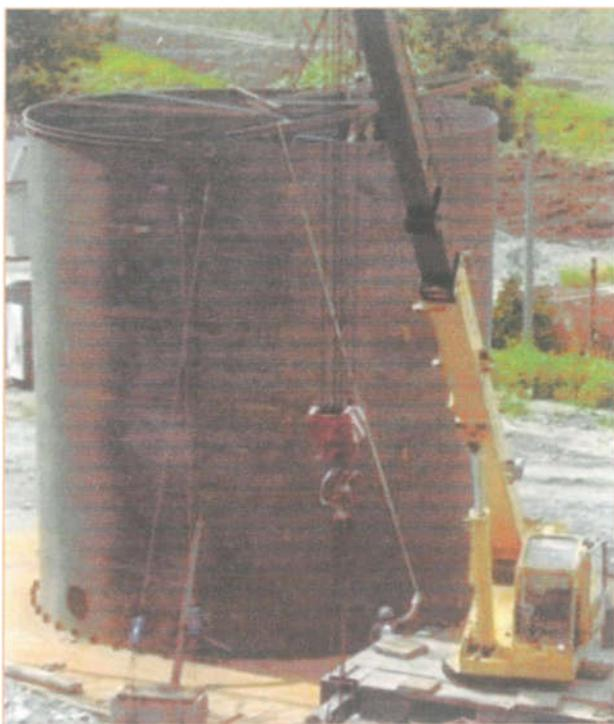
Рисунок 4- Резервуар вертикальный стальной цилиндрический
